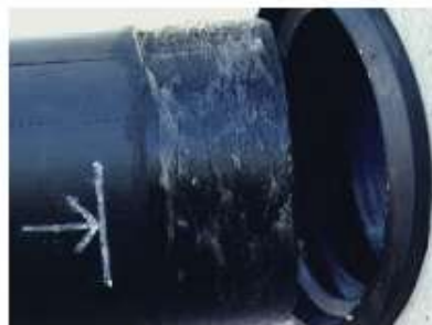
Bild 8: Herstellen der Rohranschlüsse
